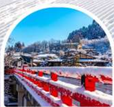
สะพานนากะบาชิ
